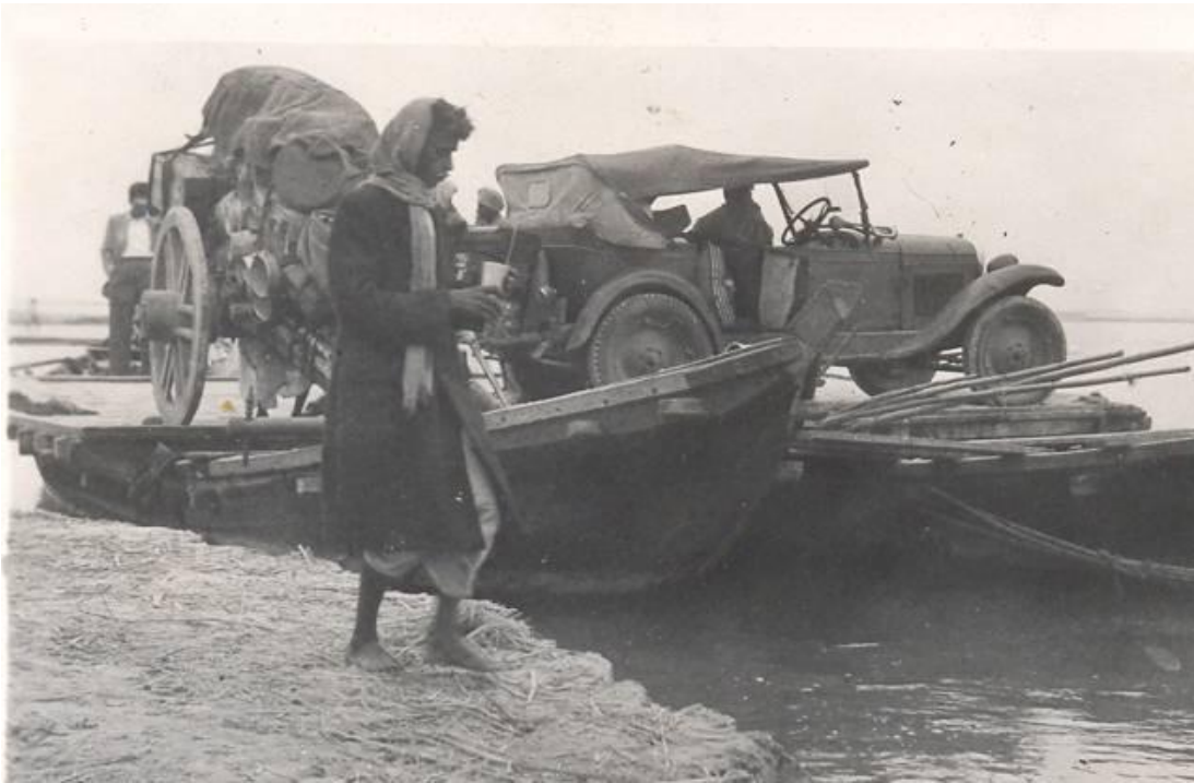
Unser FORD auf der Fähre wie zu Moses Zeiten, vor der Überquerung eines Flusses
